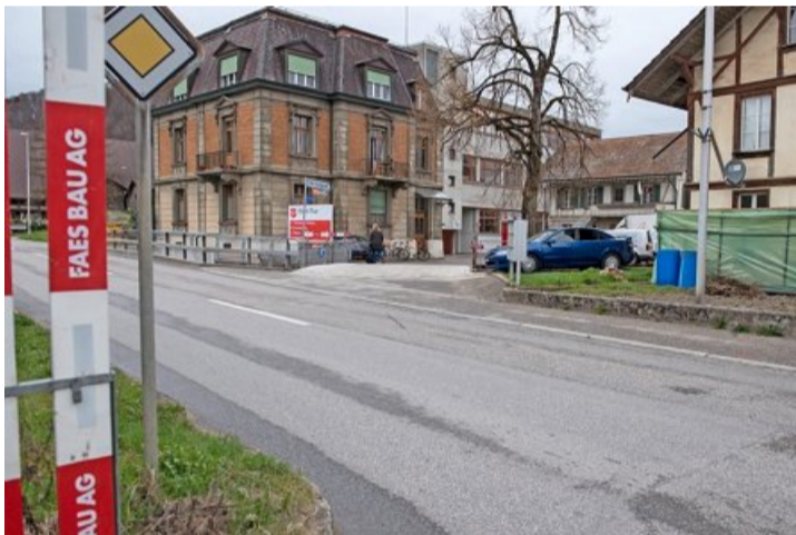
Die Brücke über den Luterbach wird neu gebaut und verbreitert.
