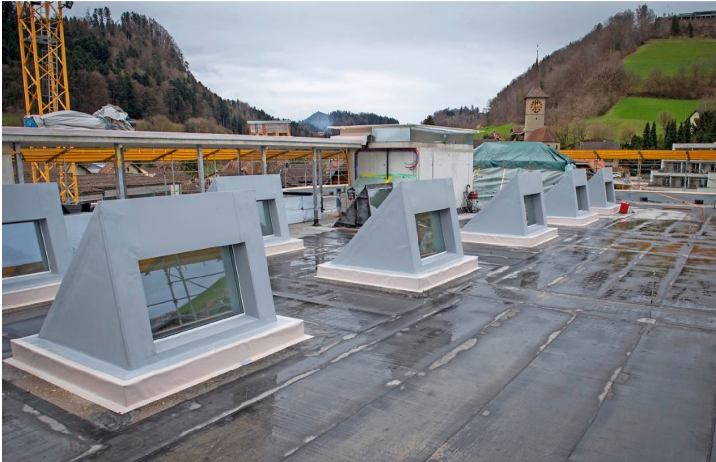
Spezielle Lichtkuppeln auf dem Dach des Neubaus sorgen für zusätzliche Helligkeit in den Werkstätten.
